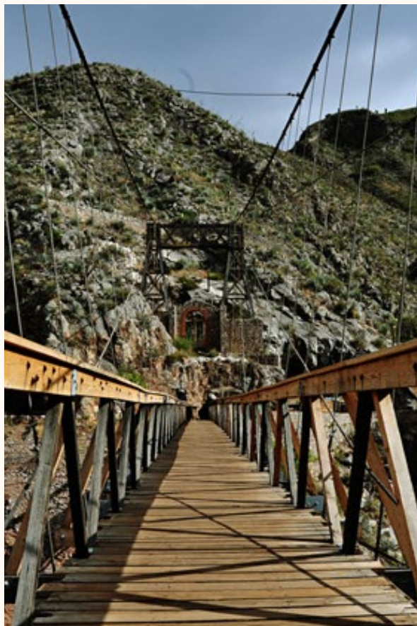
Puente de Ojuela, Mapimí
