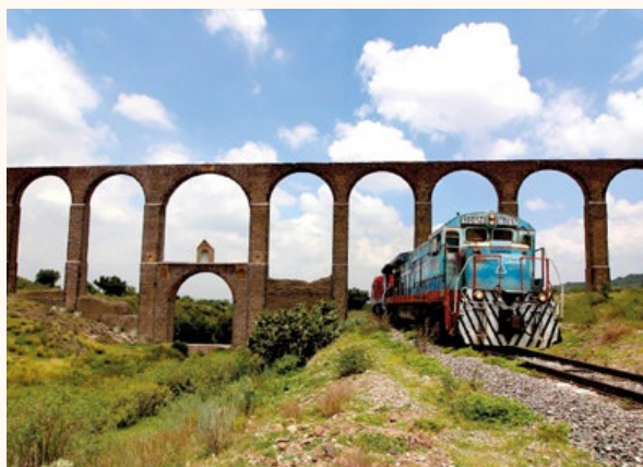
Acueducto del Padre Tembleque, Zempoala
